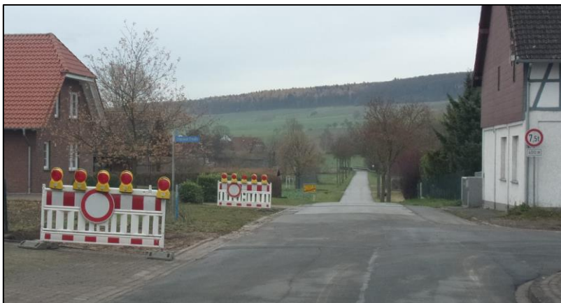
Foto nach Abriss des Gebäudes
