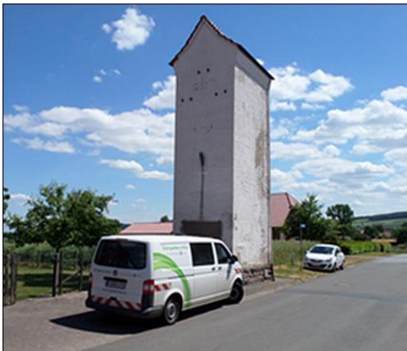
Ehemalige Trafostation in Eilensen 2
