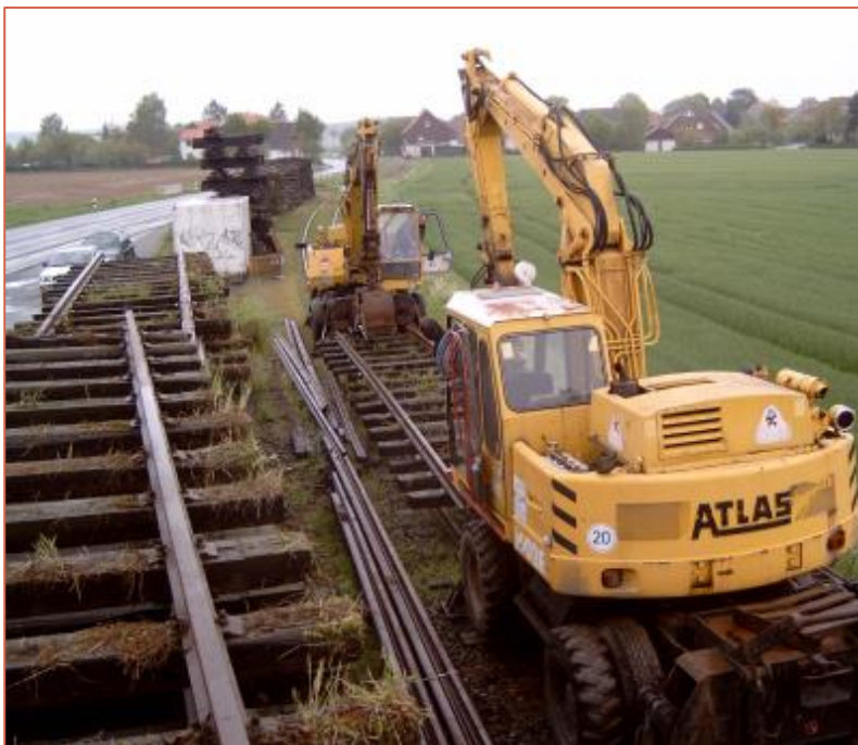
Rückbauarbeiten an der ehemaligen Rübenverladestation Eilensen
